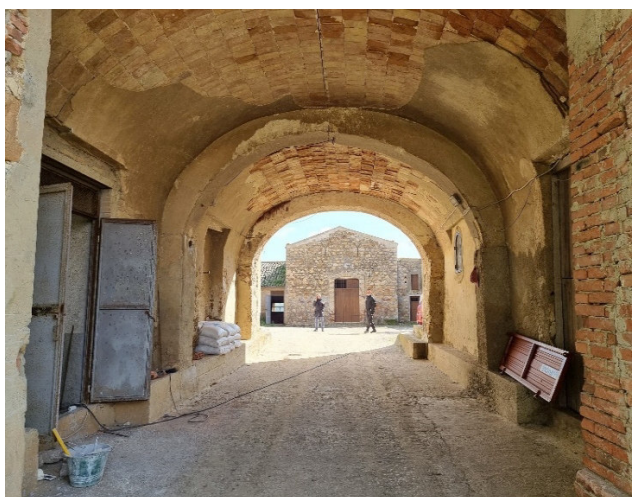
Fig. 14 Vista dell'androne d'ingresso con volta a botte
