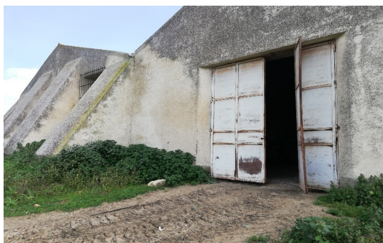
Fig. 10 – 11 Vista dei contrafforti intonacati sul prospetto laterale ed ingresso del magazzino 5
