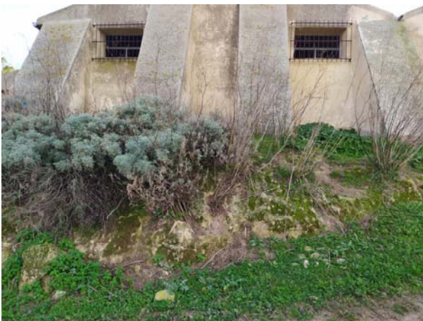
Fig. 7.1 Immagine dimostrativa di parte dell'edificio oggetto di studio che documenta il piano di posa delle fondazioni nelle suddette arenarie di sedime
