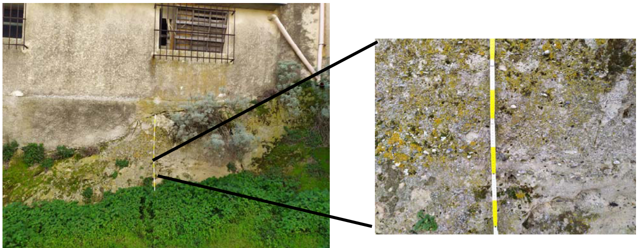
Figura 3.1 foto del terreno di fondazione e relativo dettaglio stratigrafico prospetto NE
