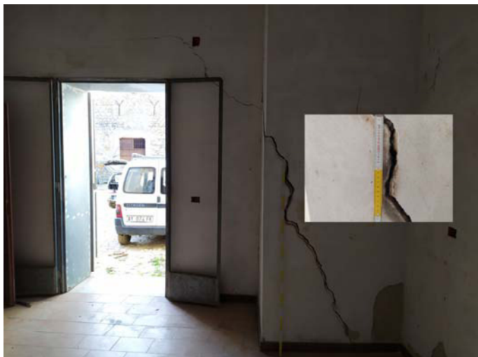
Fig. 5.5 e 5,6 Immagine dello stato attuale della lesione che coinvolge l'angolo interno del fabbricato che si affaccia nel cortile della masseria contrassegnato dall'ellisse in rosso in Fig.5.1
