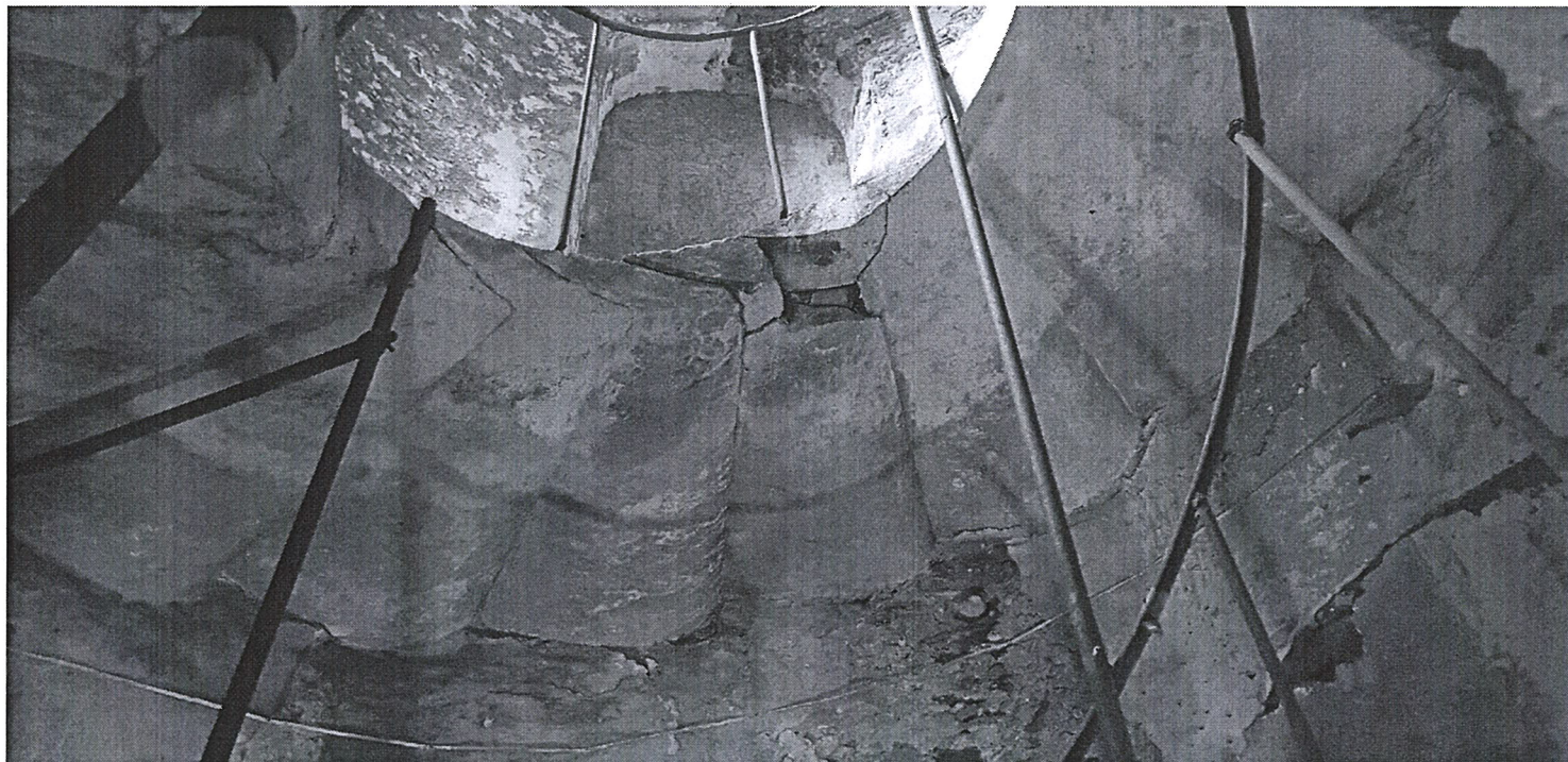
FOTO 7 scala a chiocciola lapidea – evidenti parti deteriorate
