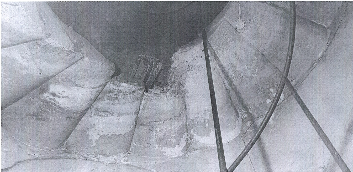
FOTO 5 – scala a chiocciola lapidea – evidenti mancanze di parti
